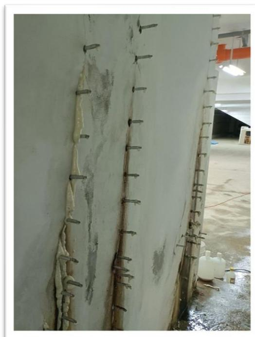
輔導棟地下室 除鏽塗佈環氧樹脂止漏
